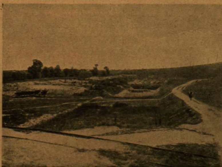
TORKOLATI ZSILIP ÉPÍTÉSE BAJÁNÁL.
